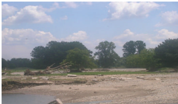
Изглед брањеног дела на месту порушеног насипа – наплавине шљунка по пољопривредним површинама
